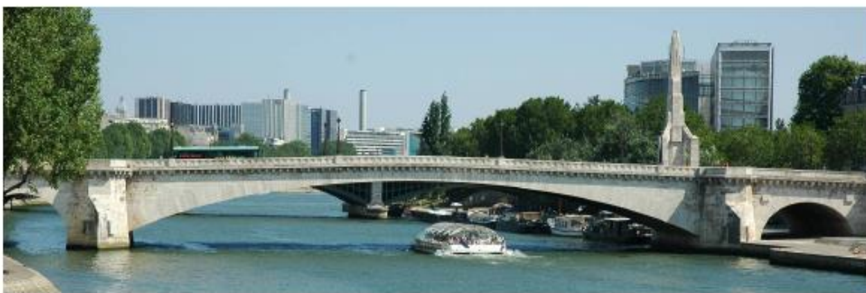
Pont de la Tourelle (Paris), pont en arc encastré d'une longueur totale de 120 m, début de la construction en 1928 et inauguré en 1930.
