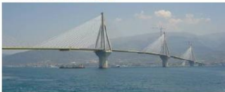
Pont de Rion-Antirion en Grèce, mis en service en 2004, d'une longueur totale de 2880 m, avec des portées de 286 m et 560 m. (1999-2004)
