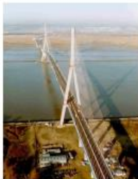
Pont de Normandie, pont à haubans d'une longueur totale de 2141 m, avec une portée centrale de 856 m (1989-1995).
