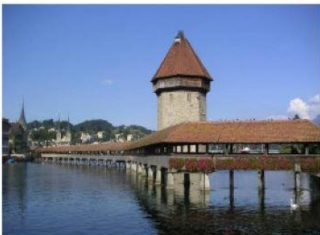
Le pont de la Chapelle à Lucerne (Suisse), construit en 1365.
