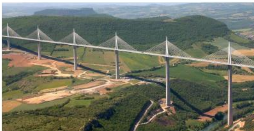
Viaduc de Millau, pont à haubans d'une longueur totale de 2460 m, avec des portées de 204 m et 342 m (2001-2004).
