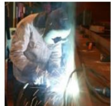
Assemblage par soudure
