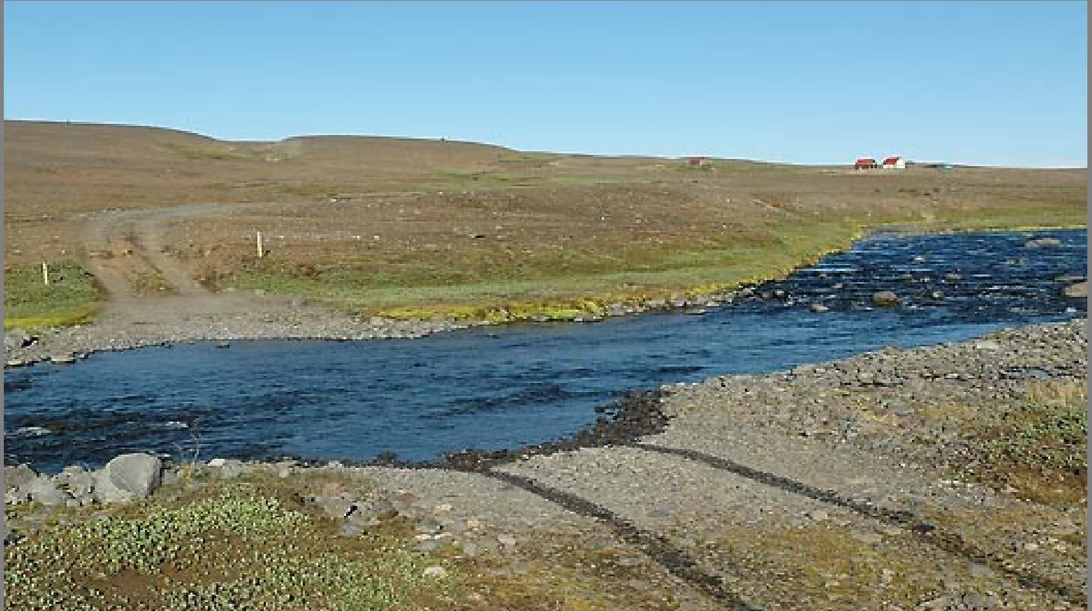
Un gué est un endroit où l'on peut traverser un cours d'eau à pied, à dos d'animal ou en véhicule sans s'embourber ni être emporté par le courant. C'est le plus simple des franchissements d'un cours d'eau, car il évite la construction d'un pont, cependant il peut être infranchissable à certaines périodes.
