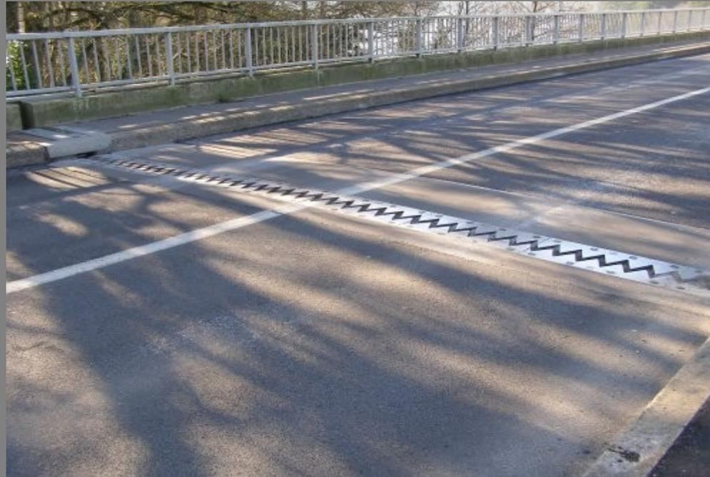
*Un joint de dilatation permet au pont de se dilater sans entraîner de désordres.*
