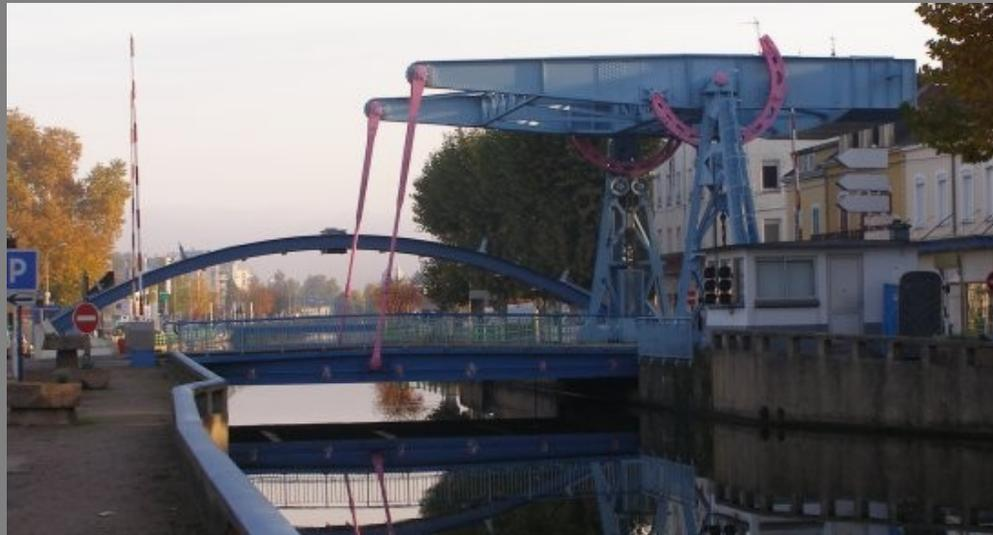
Les ponts levant permettent aussi le passage alterné de la navigation et du trafic terrestre. Ils sont adaptés à des portées assez faibles et c'est une solution assez courante sur les canaux.
