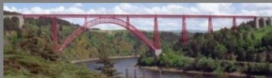
*Un pont en arc métallique en treillis*
