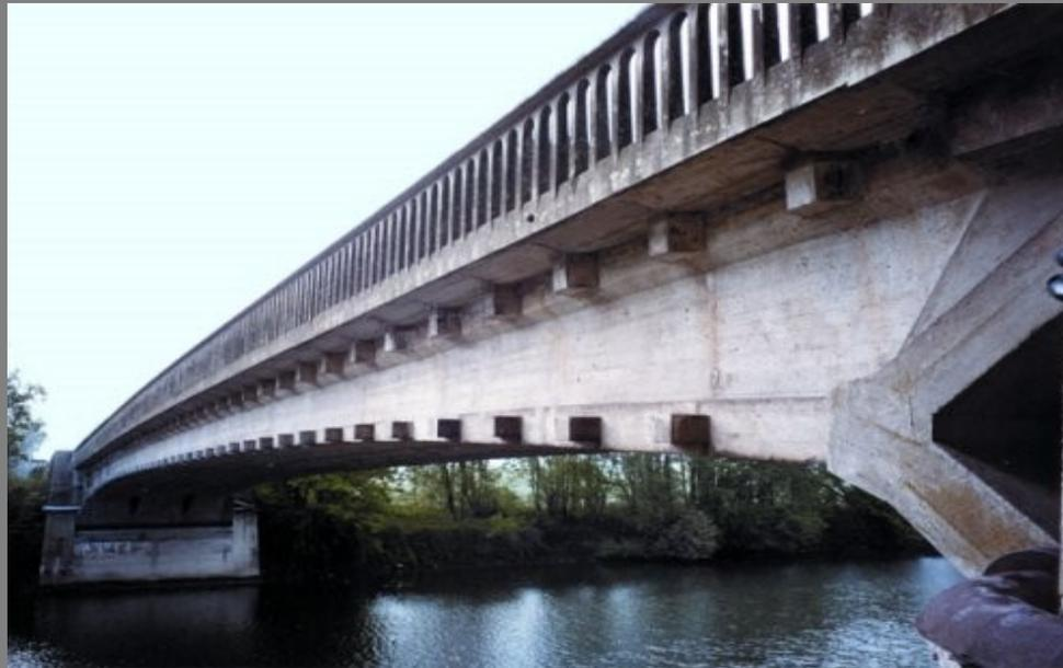
L'utilisation d'éléments en béton précontraint a permis d'augmenter les portées. Ainsi, le Pont de Lusancy, record du monde en 1946 avec une portée de 55 m.
