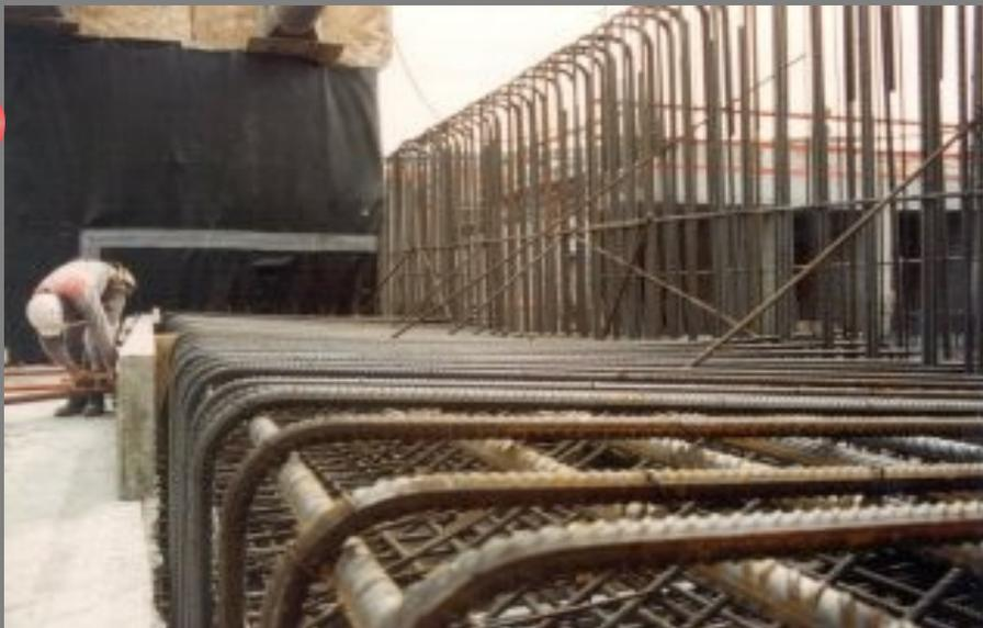
Mise en place des armatures dans un coffrage avant coulage du béton
