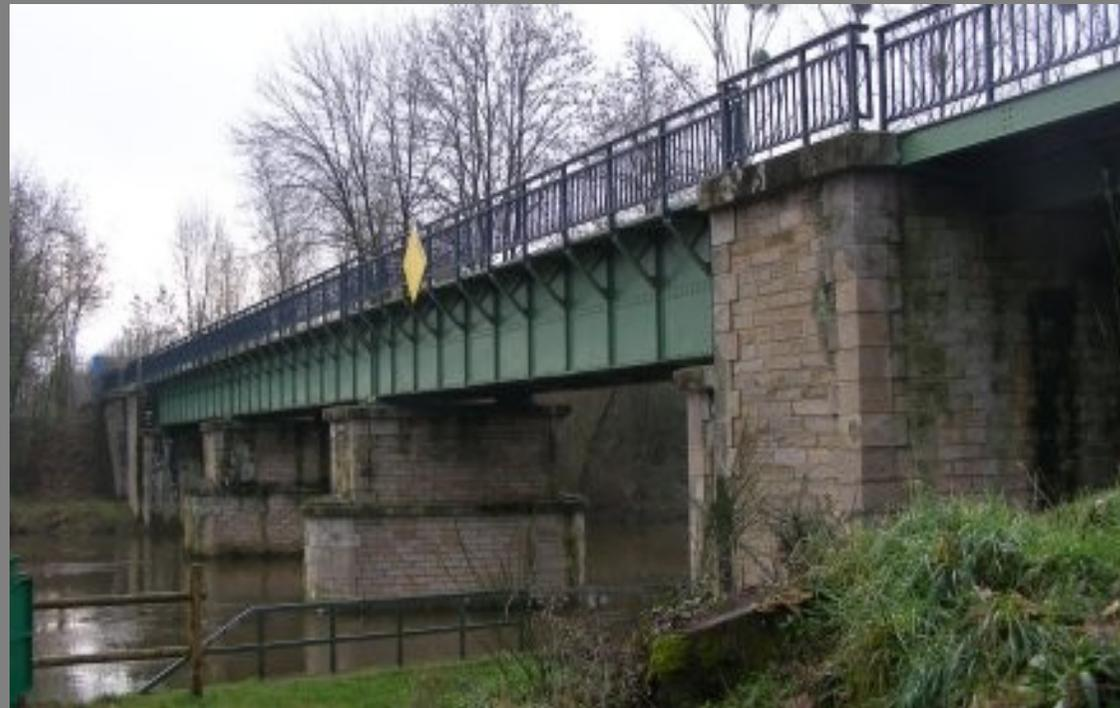
*Le Pont ferroviaire sur l'Oust à Ploërmel (Morbihan) est un bon exemple de pont poutre métallique. Il a été conçu par Gustave Eiffel quand celui-ci travaillait pour la Société des Chemins de Fer de l'Ouest.*
