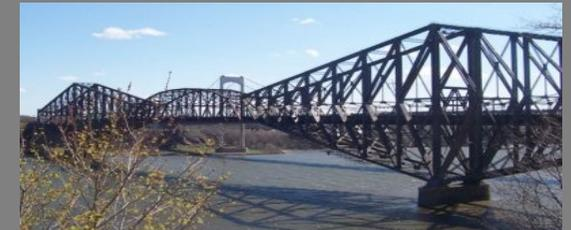
*Un pont à poutre cantilever en treillis*
