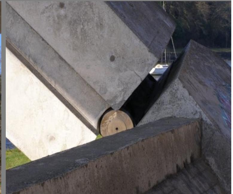
Un pont à béquille est supporté par des appuis obliques. Cette technique, qui diminue la portée principale de l'ouvrage nécessite des procédés de fabrication plus complexes. Cette technique permet de réaliser des ouvrages métalliques (poutres caisson) ou en béton précontraint.
