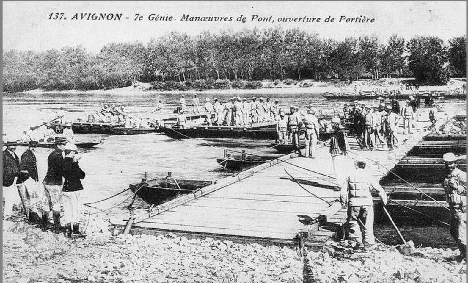
Dès que le rivièrè est large ou profonde, le franchissement du cours d'eau par gué ou passerelle n'est plus possible. Une des solutions est le pont de bateau, où un tablier est supporté par des chalands.
