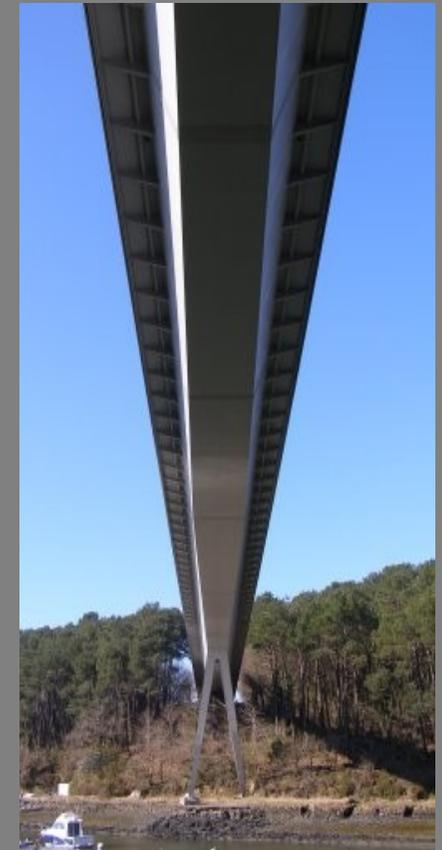
Le pont à béquilles est un pont dont les appuis sont constitués de poteaux inclinés. Cette technique a pour avantage de diminuer la portée principale du pont, mais elle nécessite des techniques de construction plus complexes que celles utilisant des piles verticales
