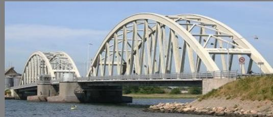
*Un pont en arc à tablier suspendu*
