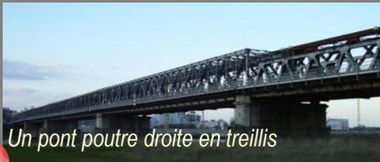
*Un pont poutre droite en treillis*
